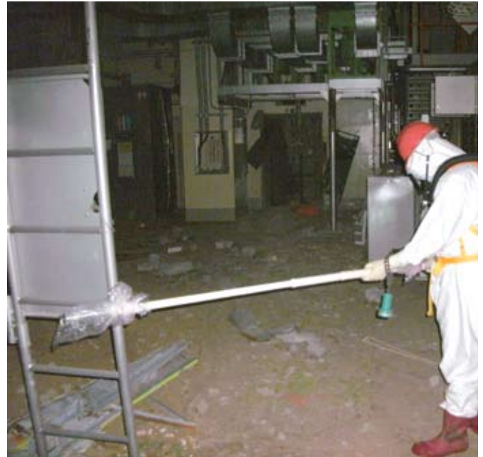
عامل يقوم بفحص الإشعاع داخل مبنى مفاعل فوكوشيما
